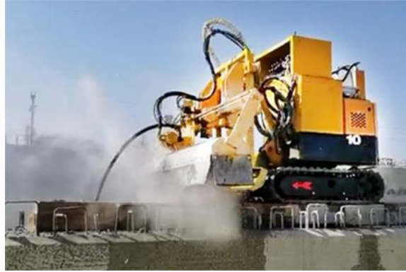
图1 高压水射流破碎混凝土作业
