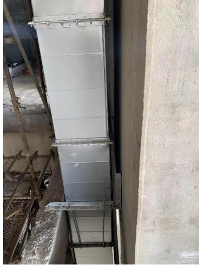
图 1 管道井狭小空间场景图
