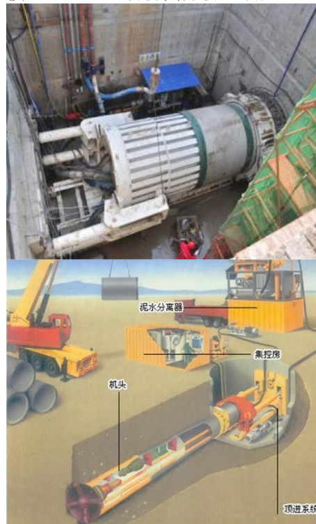
图 1 顶管机现场施工示意图
